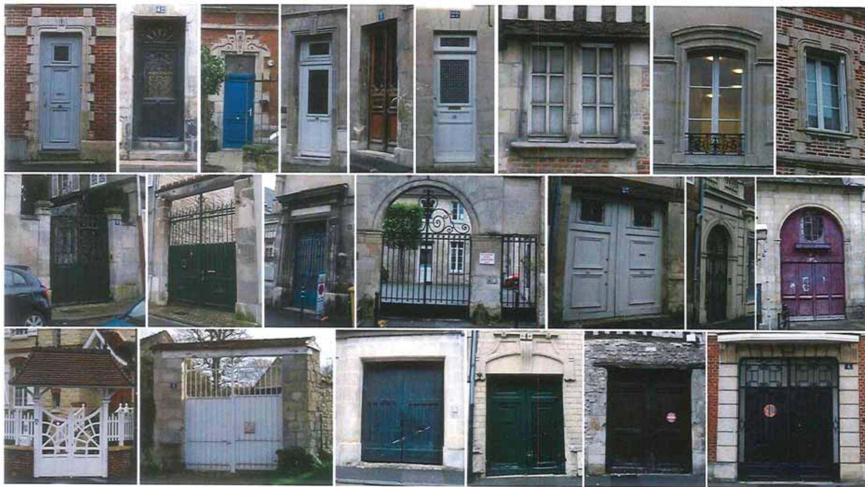
Illustration 60 : Repérage des baies et leurs fermetures
