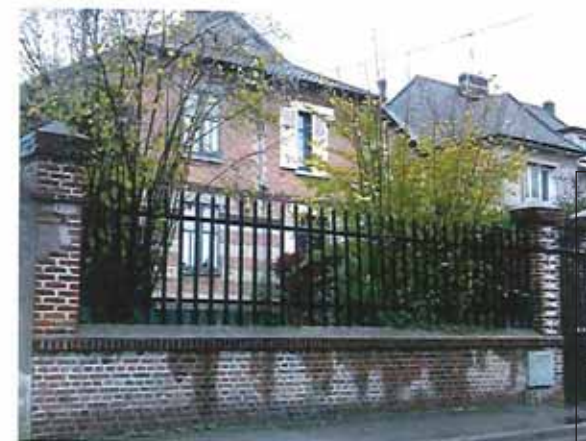
Rue du Bataillon de France
