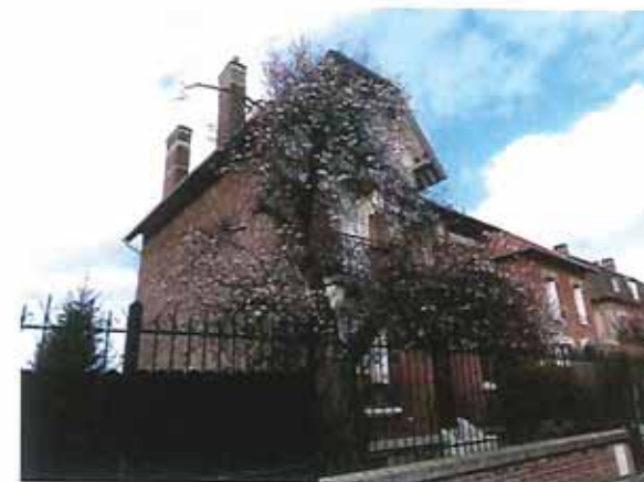
Pose d'un pare-vue uniquement sur la partie portail / Rue de Metz
