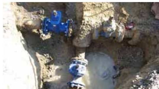
Vannes n° 508 et 509
