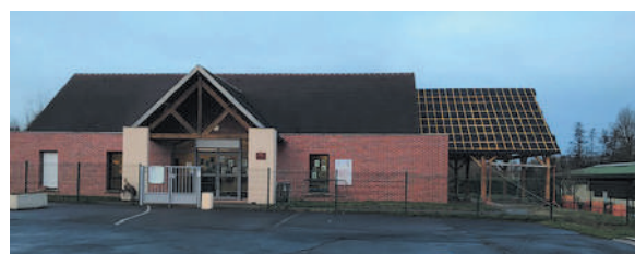
▲ Travaux importants dans les écoles, en 2018
