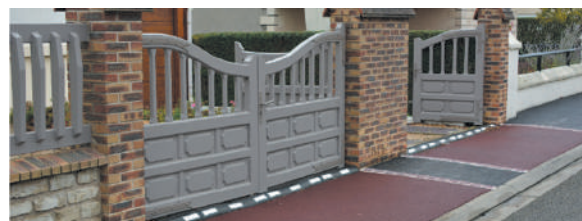
▲ Travaux de rehausse des entrées des habitations
