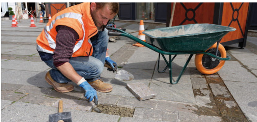
Entretien des pavés en Centre-Ville
