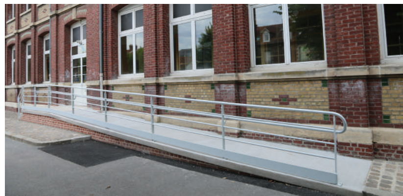
La toute nouvelle rampe d'accès pour handicapés à l'école Hersan
