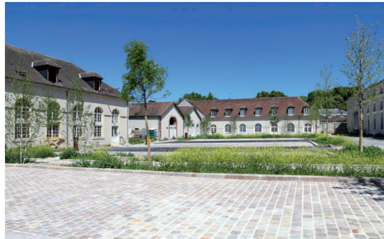
Aménagement de l'École d'état-major, ici la cours d'Honneur
