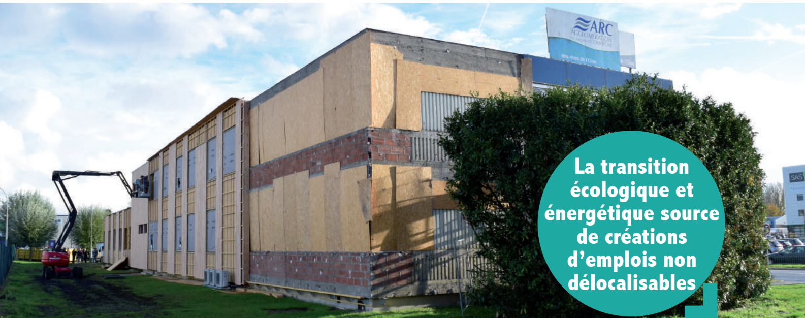
Rénovation thermique au Parc technologique des rives de l'Oise avec du bois local
