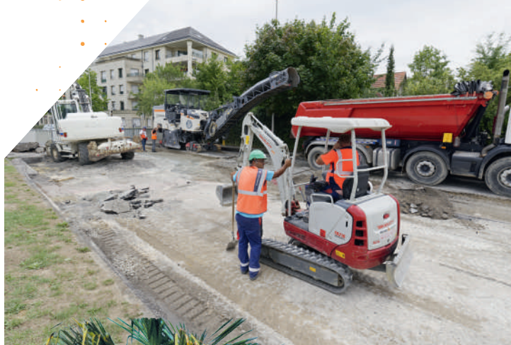
Travaux : rue de l'Oise et rue du Port à bateaux
