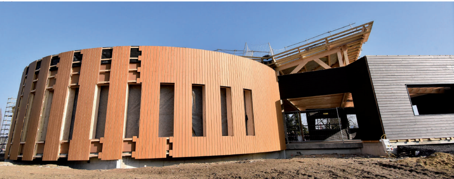
Le siège de la Fédération du Bâtiment en construction ZAC Mercières
