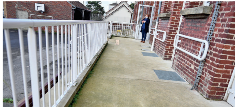
Création d'une rampe d'accès à l'école Augustin Thierry.
