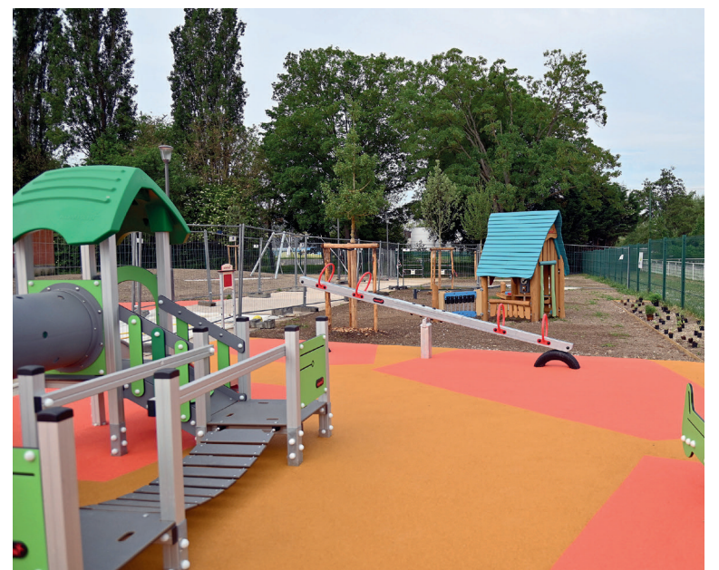
L'aire de loisirs du Clos des Roses, actuellement en cours de réalisation, sera inaugurée samedi 2 juillet à 16h.
