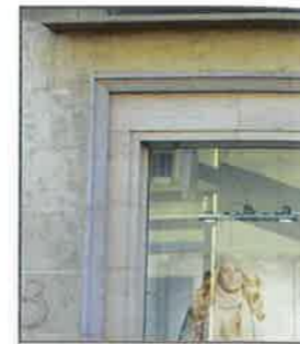
Encadrement en béton d'une baie en feuillure
