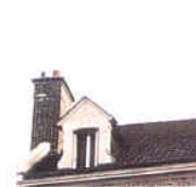
Lucarne maçonnée en bâtière.
