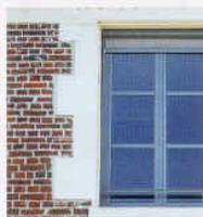
ravalement de mur de brique, joints à la chaux avec un appareillage panerasse/boutisse, occultation par un store intégré
