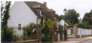
mur de pierre en blocage avec chaînes et couronnement en brique avec bande herbeuse
