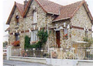
Si les murs sont en brique, les encadrements de baies, les **linteaux**, les appuis de fenêtres, les lucarnes, les **harpes**, les **bandeaux**, les corniches, les **rampants de pignons** peuvent être en pierre de taille.
