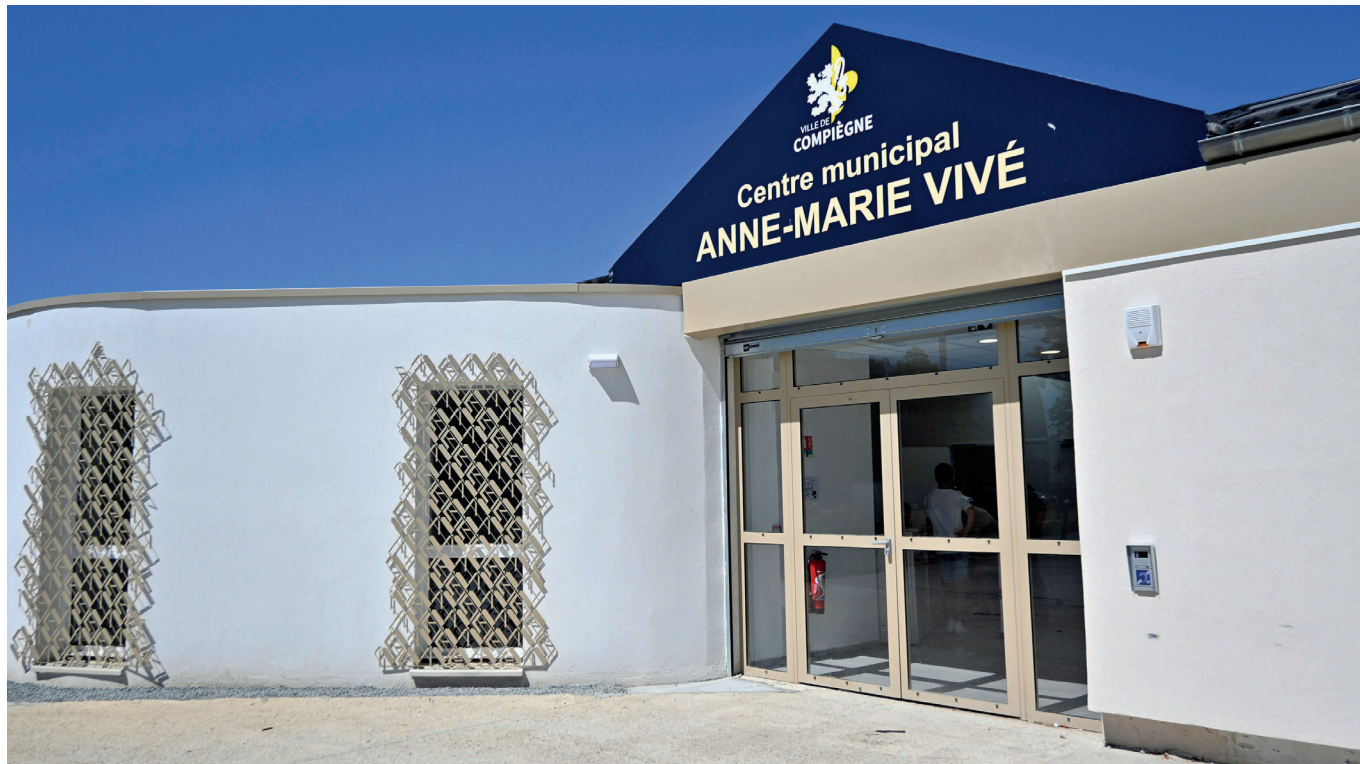
Le Centre Anne-Marie Vivé a bénéficié d'une cure de jouvence et d'une extension de 82 m 2 . Les travaux ont été inaugurés lors de la fête du quartier du Clos des Roses.
