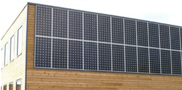
Illustration 28: Intégration en façade
