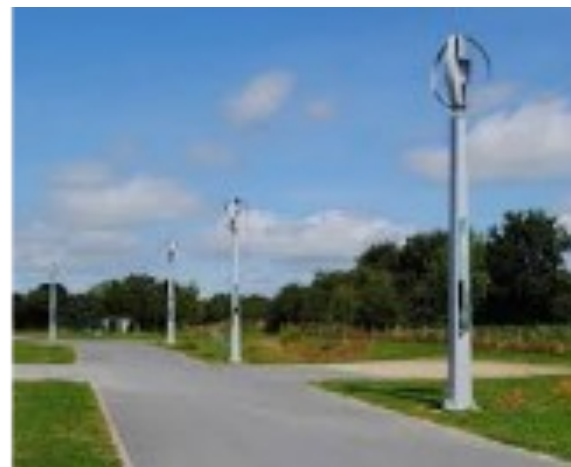
Illustration 38: Exemple de maté d'éclairage équipés de micro-éoliennes
