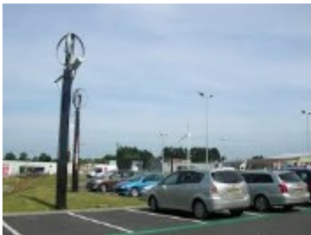
Illustration 38: Exemple de maté d'éclairage équipés de micro-éoliennes
