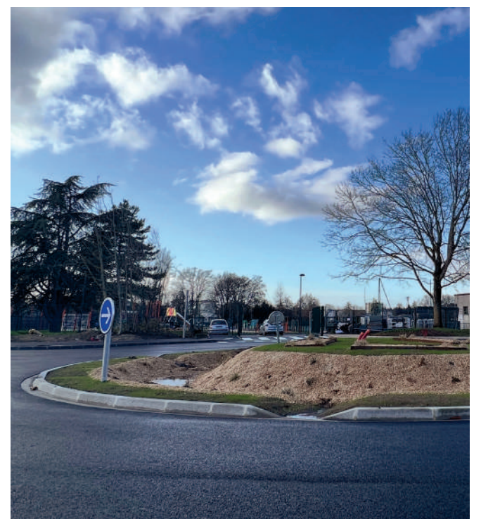
L'ensemble des eaux de pluie est désormais collecté au centre des nouveaux giratoires, comme ici Avenue de Bury Saint-Edmunds.
