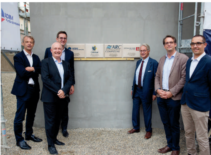
La première pierre des Subsistances a été posée. Ce projet immobilier, à l'angle des rues Othenin et de la 8 e Division sera composé de 64 logements neufs, et de 18 logements rénovés dans l'ancien hôtel de commandement de l'armée de terre, préservant ainsi le passé militaire de Compiègne.
