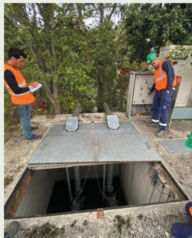
Ces postes de crues permettent aux habitations de ne pas être inondées par les eaux de pluie qui ne s'écouleraient plus lors d'une crue, grâce à l'action d'une vanne qui ferme le réseau pluvial tandis qu'une pompe rejette cette eau dans la rivière.
