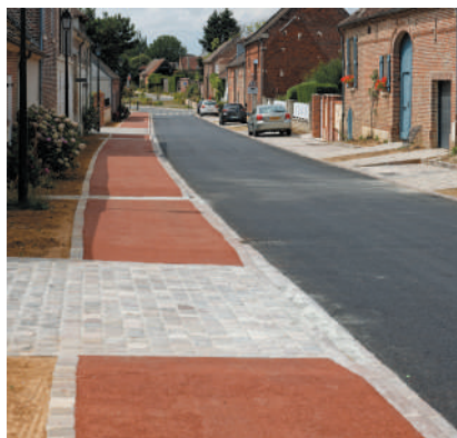
Les travaux de voirie
