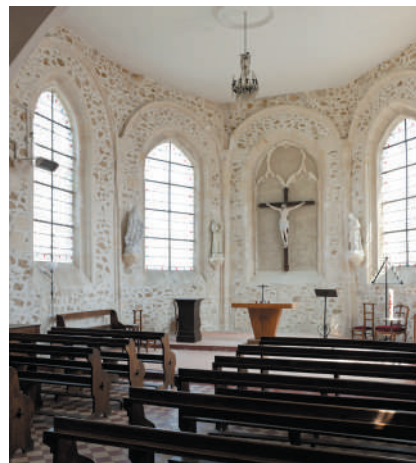
Les travaux de rénovation de l'église Saint-Nicolas
