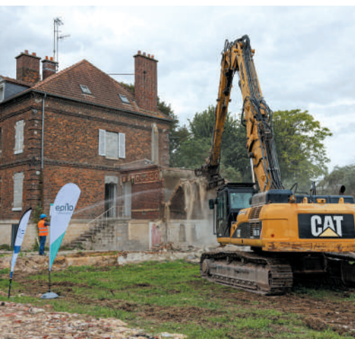
Première destruction pour le futur ÉcoQuartier de la gare
