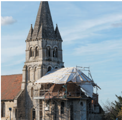
Les travaux de restauration de l'église
