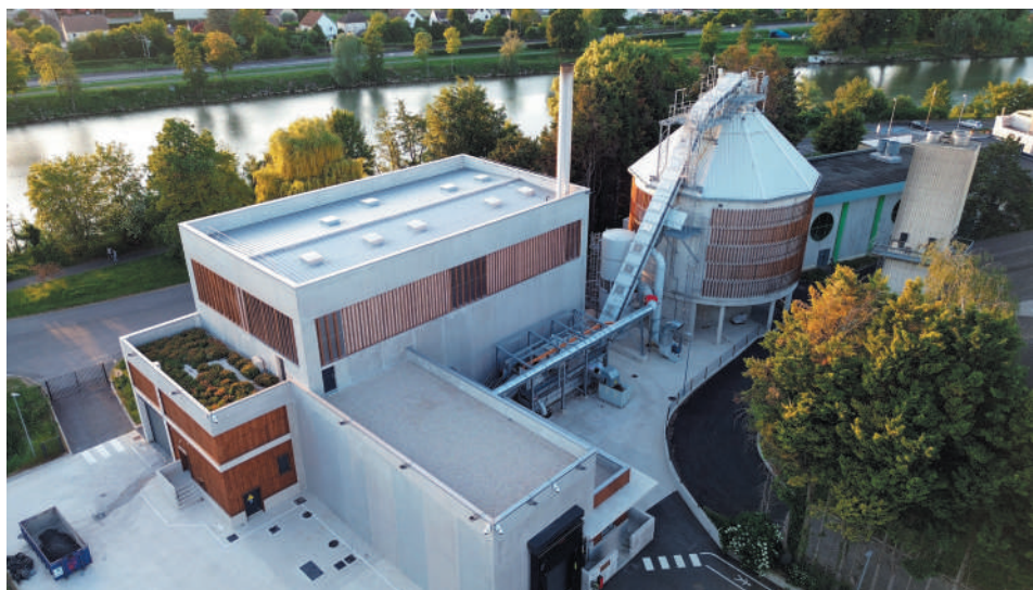
La puissance de la nouvelle chaufferie permet d'étendre le chauffage urbain
