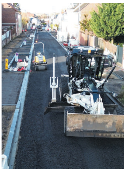
Les travaux du boulevard des États-Unis
