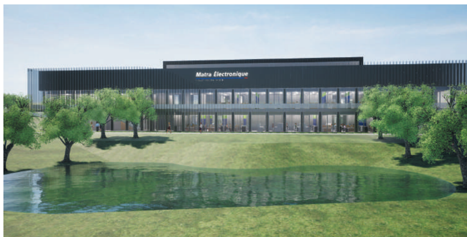
L'industriel français Matra Électronique s'installera, en 2024, dans la ZAC du Bois de Plaisance
