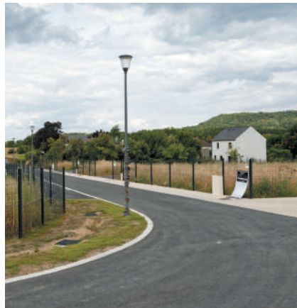
Les travaux du nouveau lotissement
