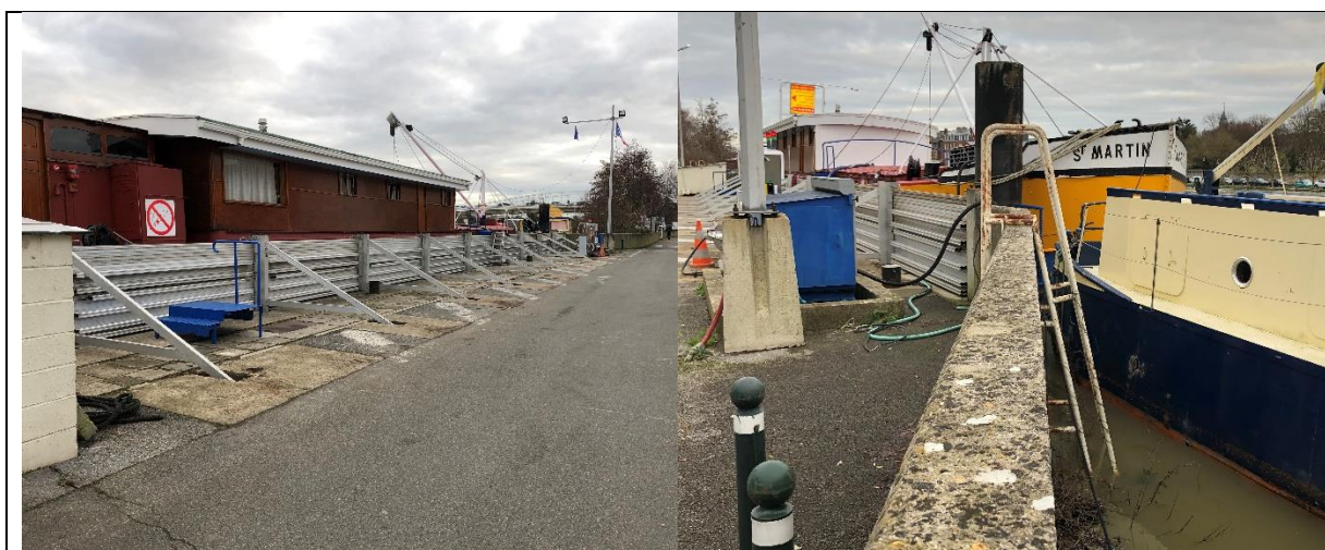
Quai de Venette : Batardeaux devant l'entreprise Guerdin
