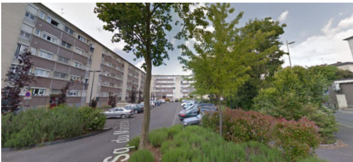
Vers le futur lot ON3, espaces en nature de voirie, stationnements et espaces verts.
