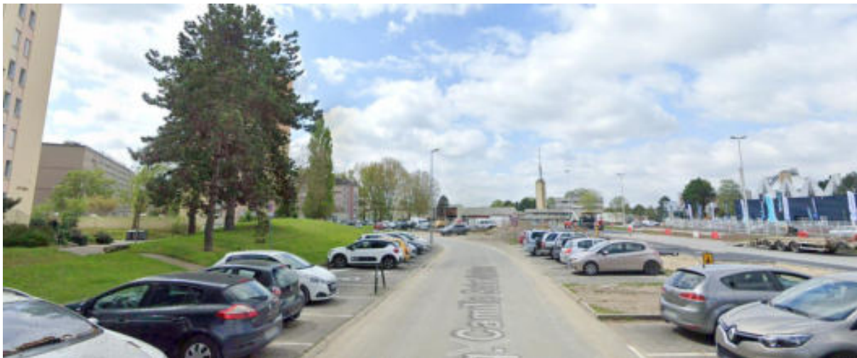
Vue vers le futur lot ON1 : espaces en nature de voirie, stationnement et espaces verts.
