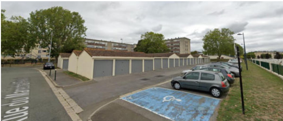
Vers le futur lot ON1, espaces en nature de voirie et de stationnement.
