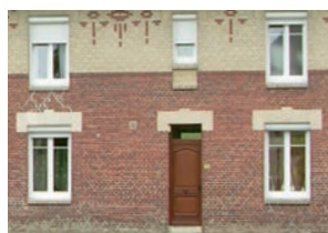
Mur en brique rouge et silico-calcaire
