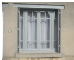
Baie avec linteau et volets métalliques pliants
