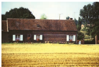
Longère en brique réhabilitée
