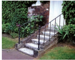
Brique rouge unie, silico-calcaire claire, vernissée et cintrée, badigeonnée en rouge, posée à chevron, formant un escalier ou un couronnement de clôture
