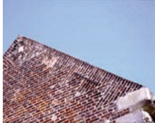
Pignon avec brique en chevron
