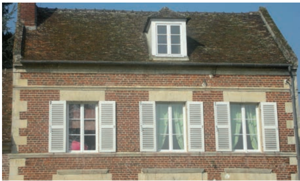
Maçonnerie mixte, volets peints persiennés
