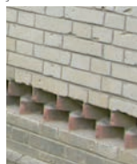
Jeux de brique créant une aération
