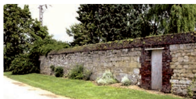
Mur de pierre en blocage avec chaînes et couronnement en brique avec bande herbeuse
