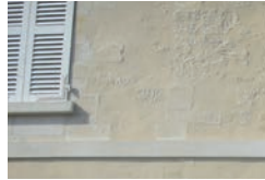
Ravalement d'enduit sur moellon
