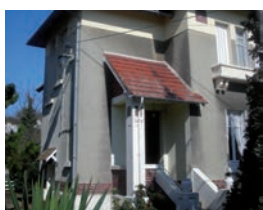
Entrée avec auvent en tuile mécanique
