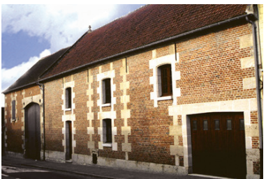
Réutilisation d'une grange en logement
