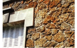
Meulière avec joint creux au mortier bâtard
