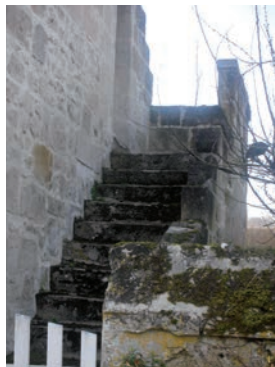
Escalier en pierre sur pignon
