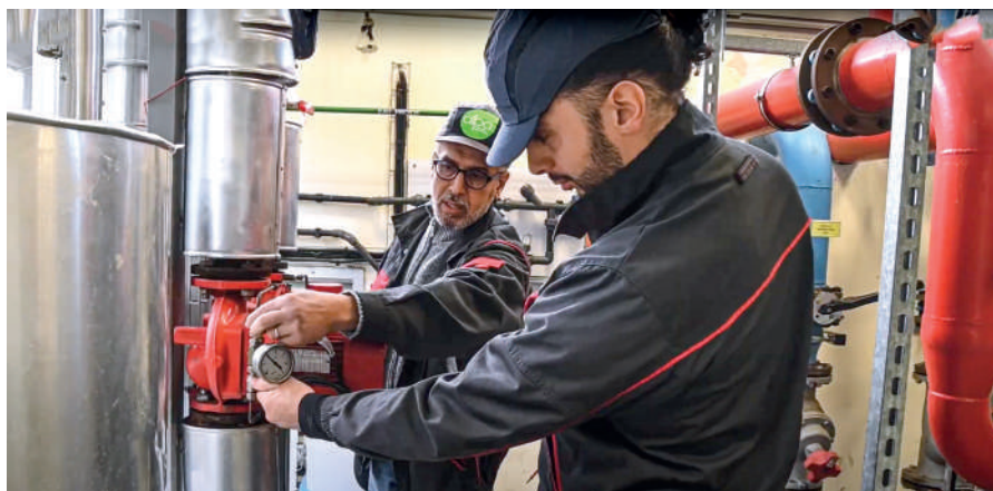
Formation au métier de technicien de maintenance en chauffage, ventilation et climatisation
